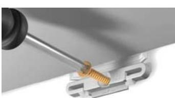
fissare la clip tramite la vite esattamente sull'angolo tra parete e soffitto
